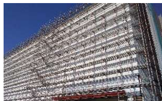
マンション工事
